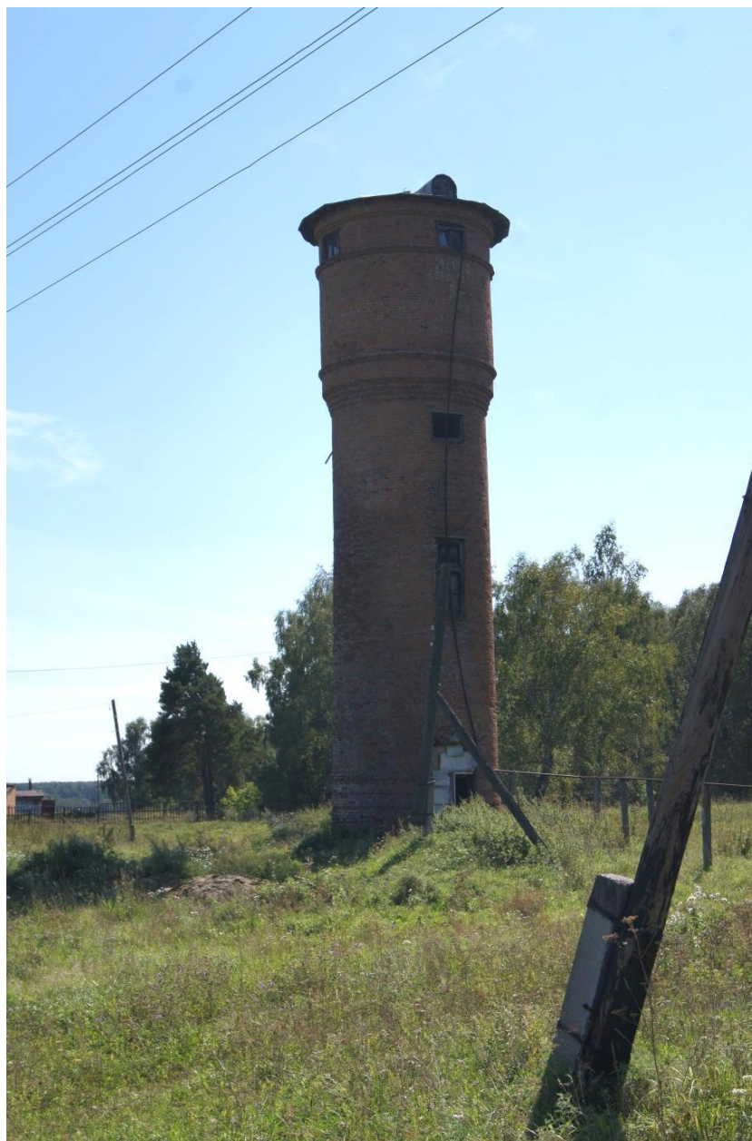
Рисунок 2.4 – Водонапорная башня вблизи рабочей скважины
