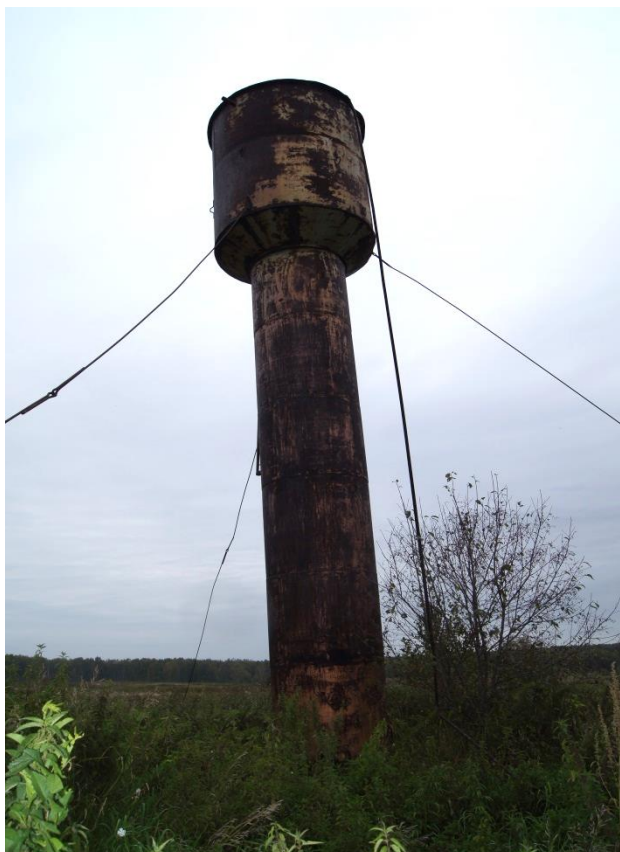
Рисунок 2.7 – Водонапорная башня вблизи скважины № 11354
