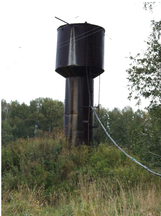
Рисунок 2.6 – Водонапорная башня вблизи скважины № 10-858
