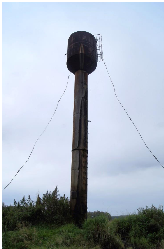
Рисунок 2.5 – Водонапорная башня вблизи скважины № 14
